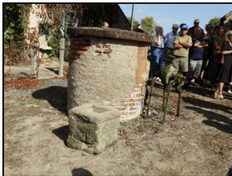
Puits des Chenaux
